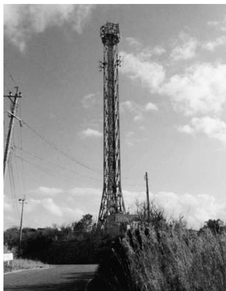
携帯アンテナ基地局
