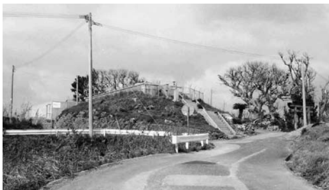
麦屋集配池（高千穂神社横にあるタンク）
