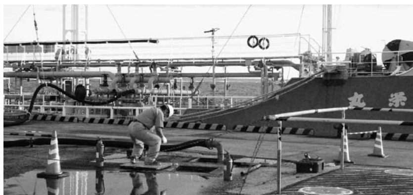
タンカーから貯留タンクへのガソリンの移送作業
